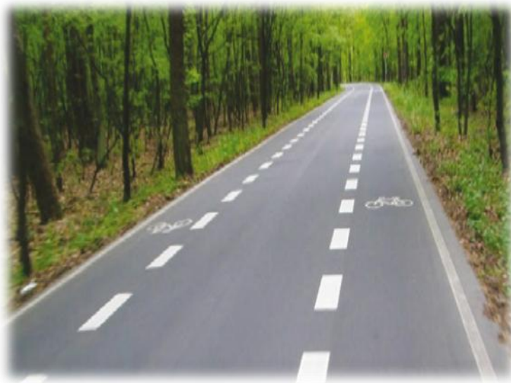
Foto.7. Pasy ruchu dla rowerów w terenie niezabudowanym, nawierzchnia asfaltowa.
