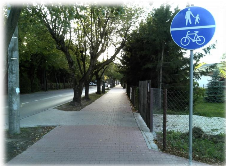
Foto.5. Ciąg pieszo- rowerowy w terenie zabudowanym, nawierzchnia z kostki betonowej Źródło: archiwum własne M&G
