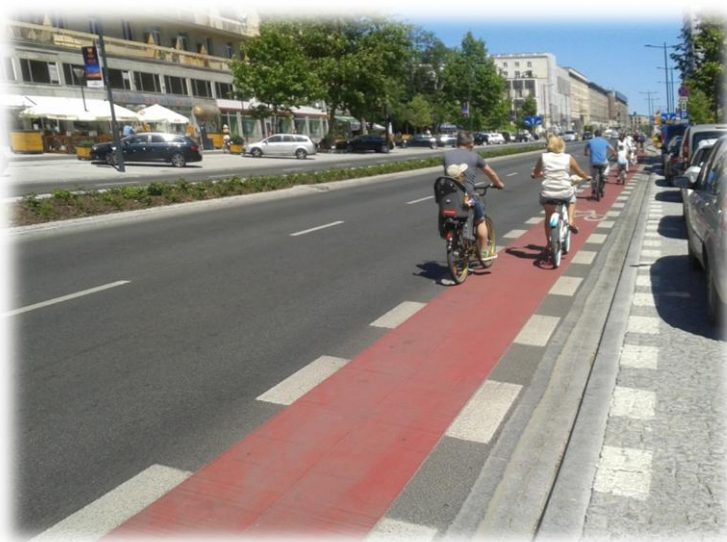
Foto.8. Pasy ruchu dla rowerów w terenie zabudowanym, nawierzchnia asfaltowa.
