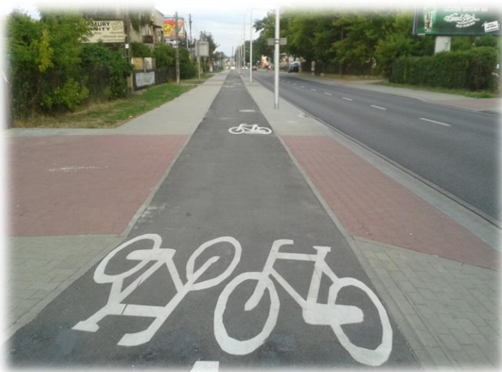
Foto.4. Ścieżka rowerowa (droga) rowerowa dwukierunkowa w terenie zabudowanym nawierzchnia asfaltowa. Źródło: archiwum własne M&G
