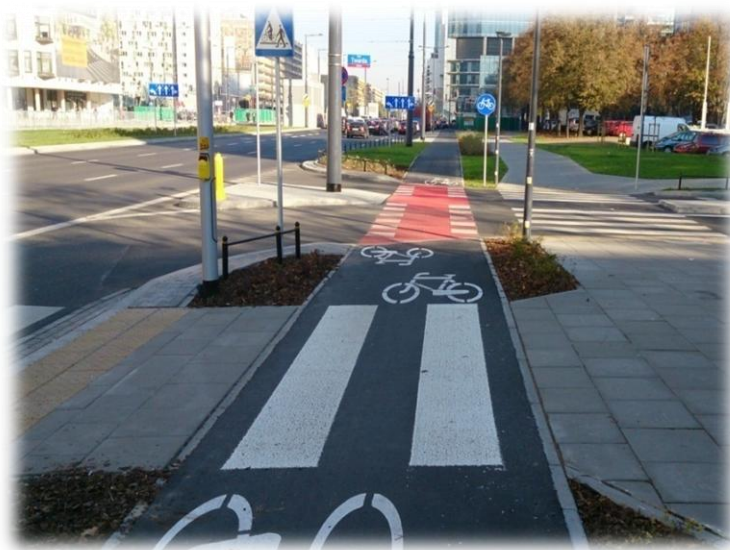
Foto.1. Wydzielona ścieżka (droga) rowerowa dwukierunkowa w terenie zabudowanym, nawierzchnia asfaltowa. Źródło: archiwum własne M&G
